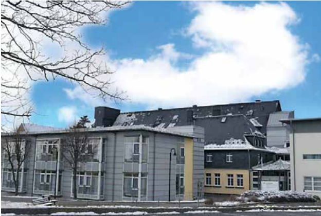
Blick auf den Eingangsbereich des alten Bergarbeiter-Krankenhauses
